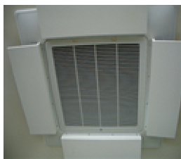
《エアコン分解清掃》
